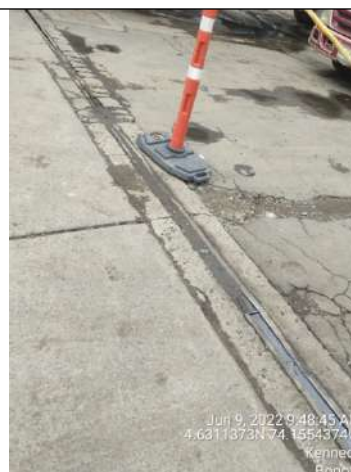
Foto 2. Pisos área de distribución y canaletas perimetrales
