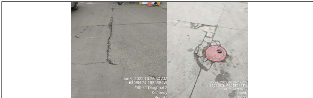
Foto 3. Pisos patio de maniobras y área de almacenamiento
