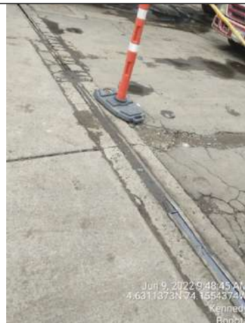
Foto 2. Pisos área de distribución y canaletas perimetrales
